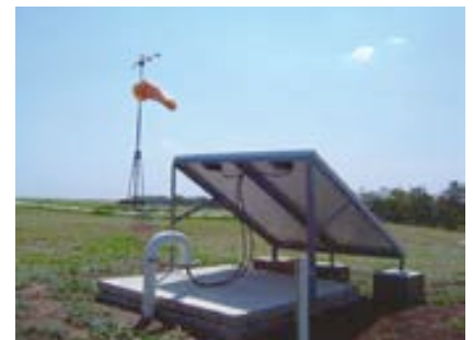
Sistema de iluminação da biruta em Viracopos é movido a energia solar
